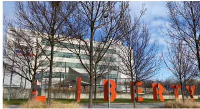
Obr. 7: Budova Rádia Svobodná Evropa / Rádia Svoboda na bývalých pozemcích židovského sportovního klubu Hagibor, v místě baráků pracovního tábora z roku 1944 (foto autor)
